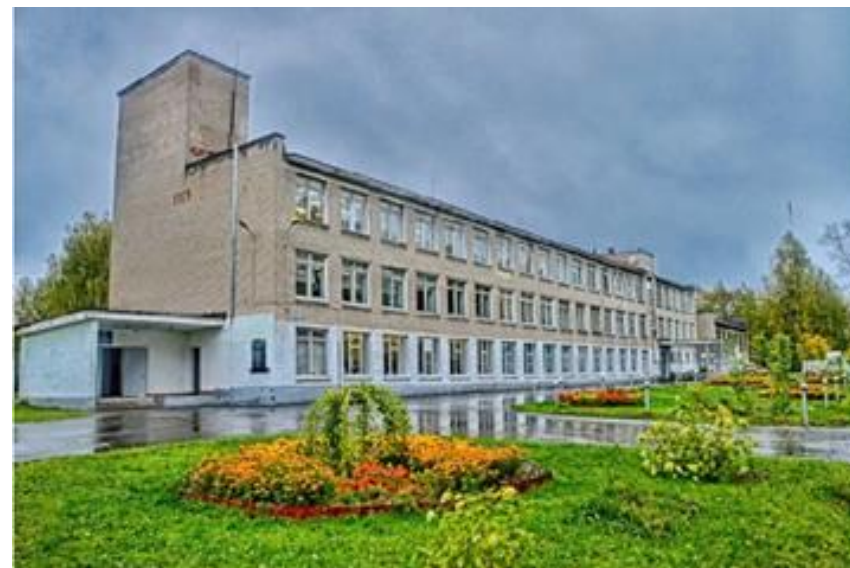
МБОУ Саваслейская школа - ремонт спортивного зала
